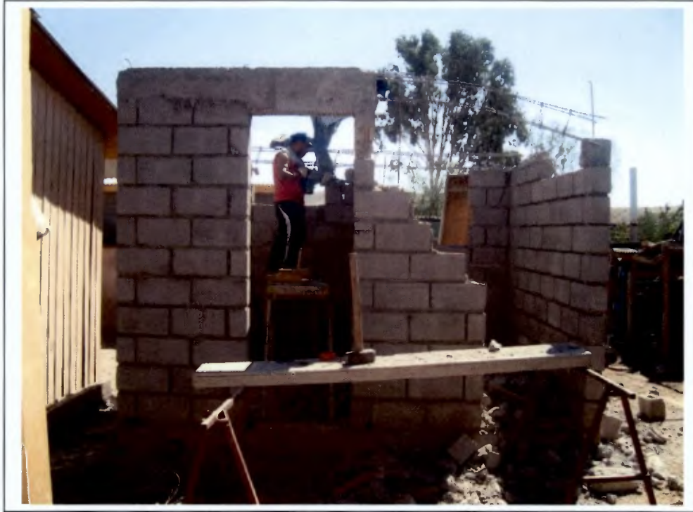
Foto N°5 Demolición y reconstrucción caseta sanitaria sitio 5 manzana 3
