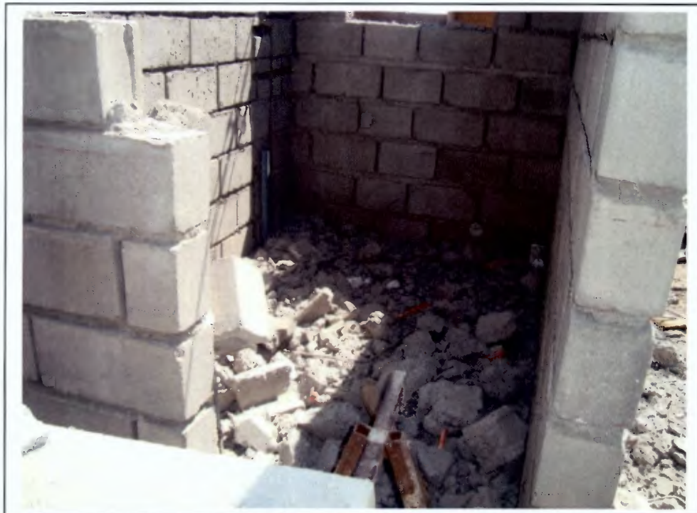
Foto N° 6 Detalle de la demolición caseta sanitaria sitio 5 manzana 3
